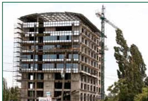
Noul Sediu al SNSPA în construcție (vedere exterioară)
