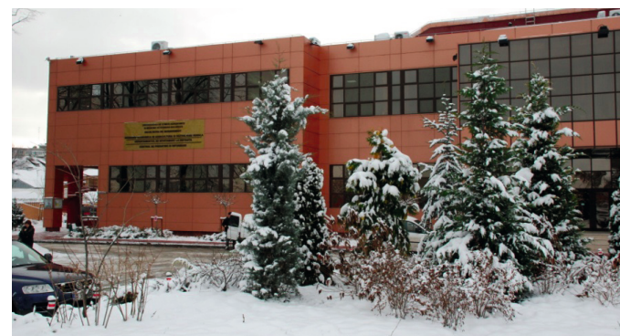
Clădirea Facultății de Management
